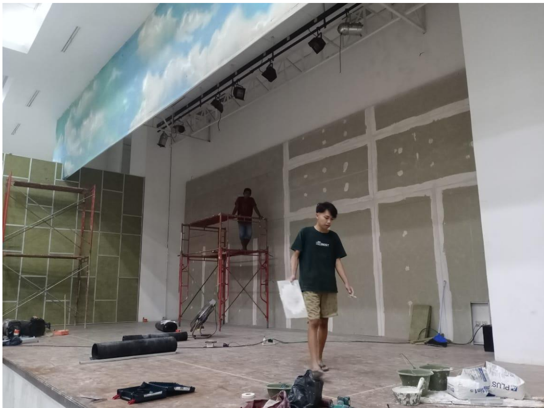
Pelaksanaan Pekerjaan GRC Board
